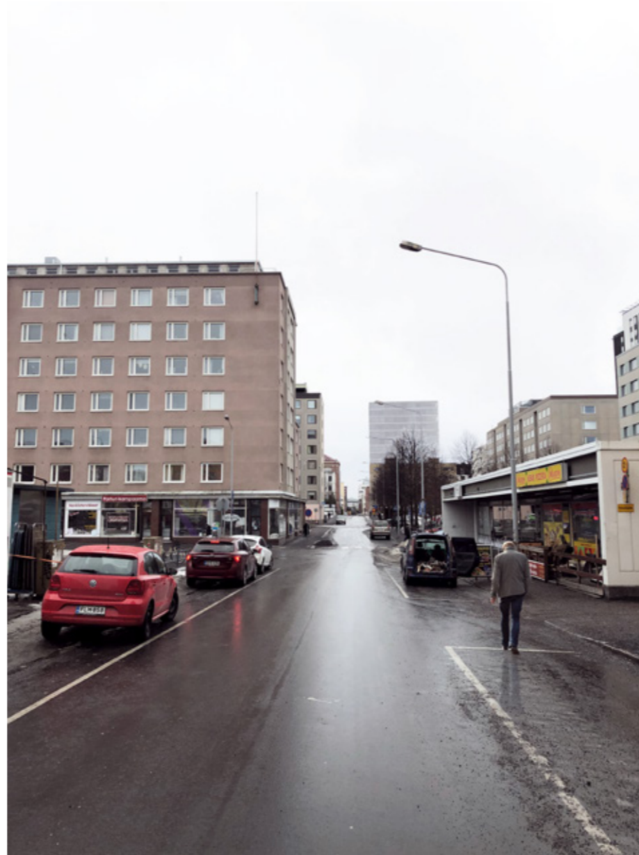
Tullikamarin ja Attilan tontin täydennysrakentamisella
