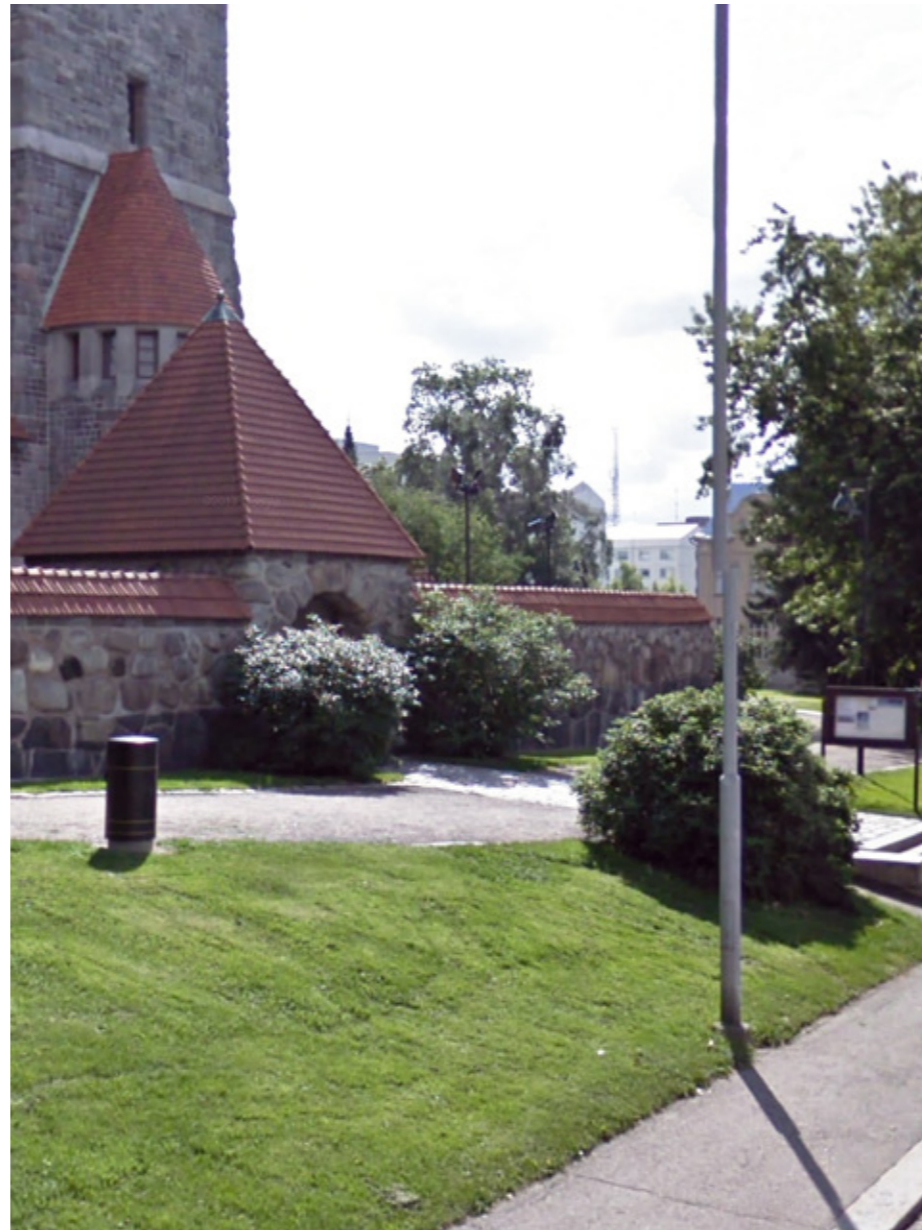
Tullikamarin ja Attilan tontin täydennysrakentamisella
