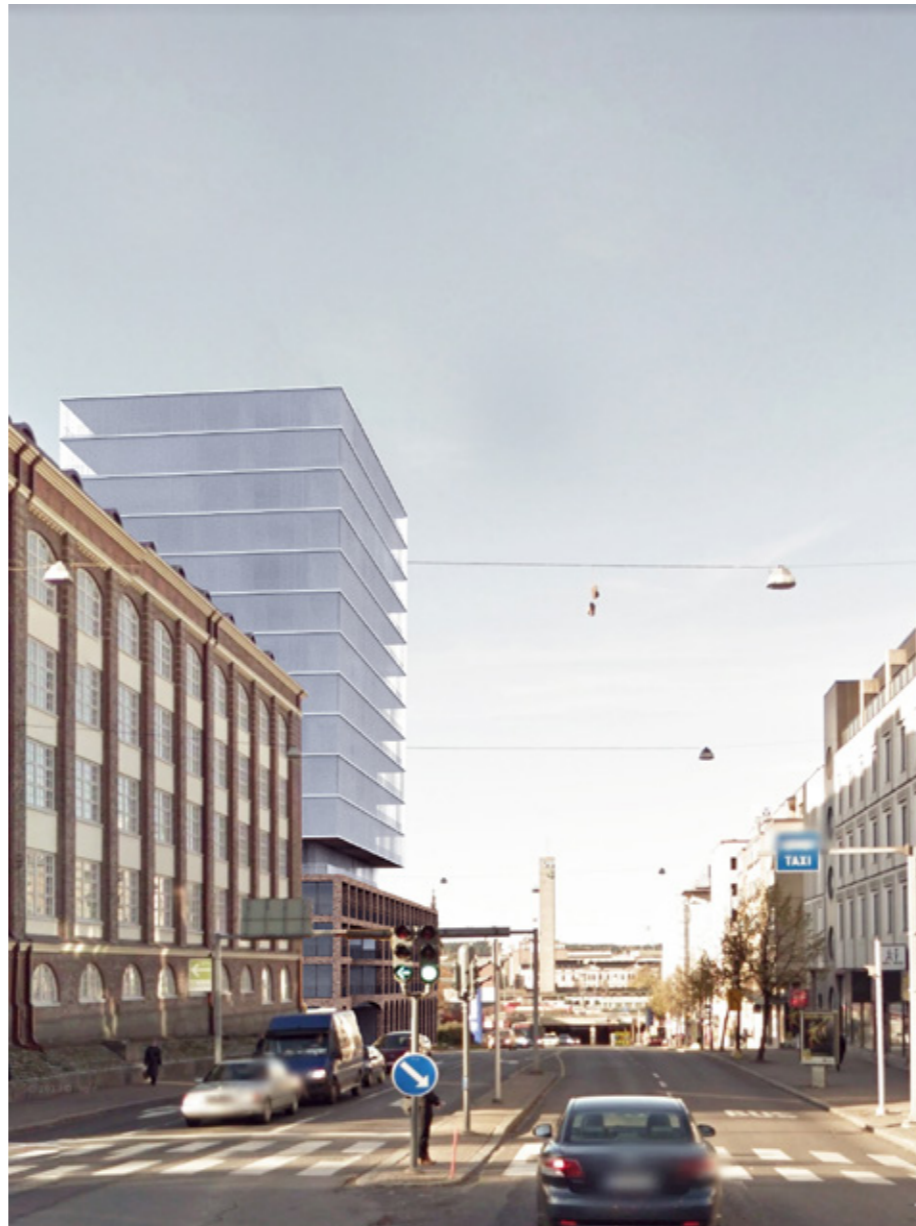
Tullikamarin ja Attilan tontin täydennysrakentamisella
